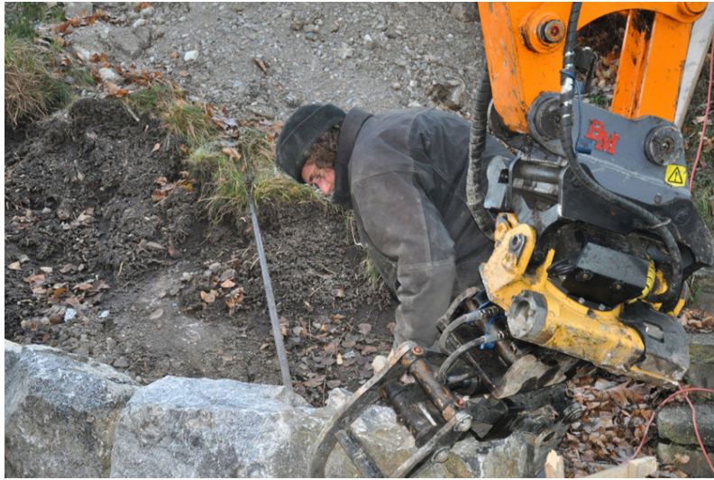
Byggande av stenmur 2011-12-08
